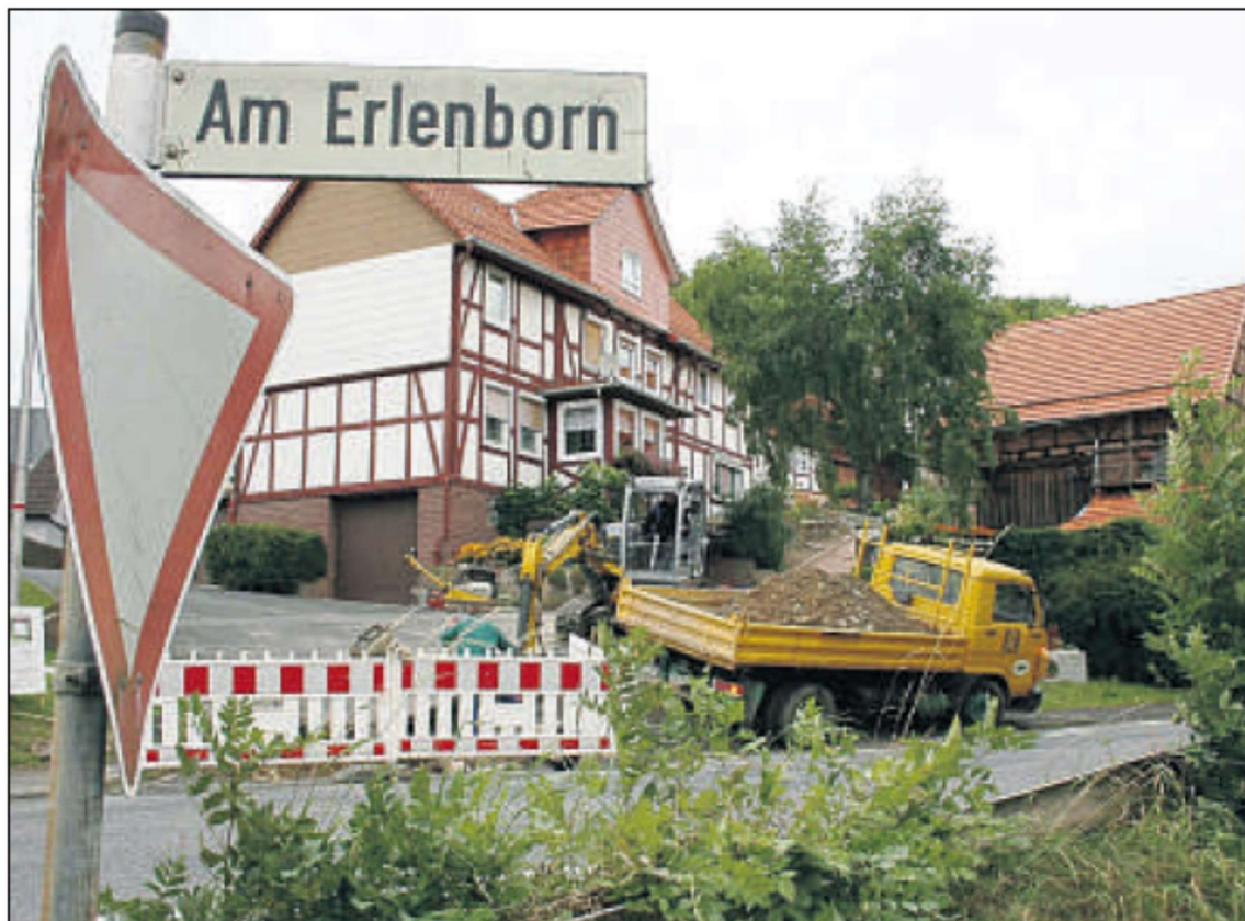
Wenig festlich: Am Iberg gegenüber der Straße Am Erlenborn waren in den vergangenen Tagen Bagger im Einsatz. Heute sollen sie vorübergehend abziehen.
