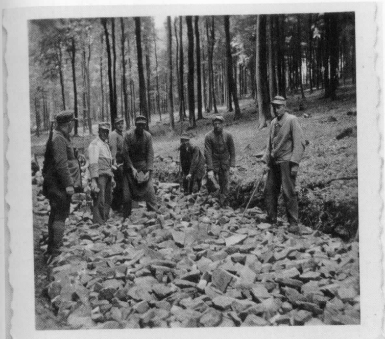
Waldwegebau in den 30er Jahren (Spangenberg)
