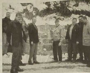
Auch die Mauer aus Bruchsteinen wurde errichtet, die alle hatte kein Fundament. Der neue Parkplatz bietet jetzt Stellplätze für 10 PKW. (Foto:bs)
