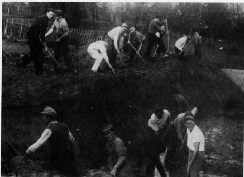
Bau des Feuerlöschteiches 1953
