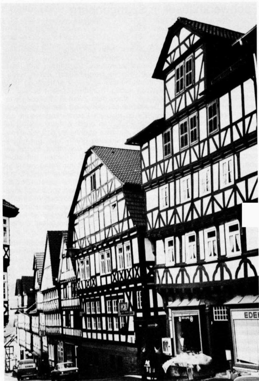
Spangenberg, spätmittelalterliche Fachwerkhäuser am Markt und in der Klosterstraße
