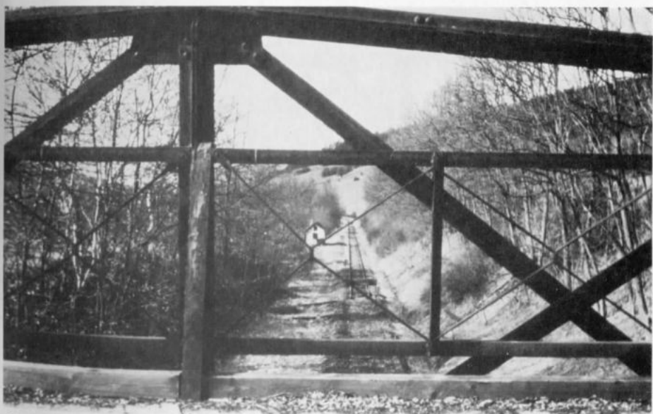
Ein Blick durch die Verstrebrungen der längst verschwundenen Beieröde-Brücke. Deutlich erkennt man, bis wohin der gesamte Schienenstrang von Waldkappel bis zur Beieröde herausgenommen wurde.
