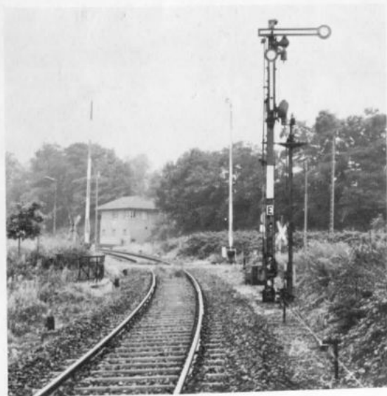
Signalmast, Schranken und Stellwerk auf dem Verbindungsgleis zur Strecke Kassel – Bebra, als hier noch regelmäßig Personen- und Güterzüge verkehrten.
