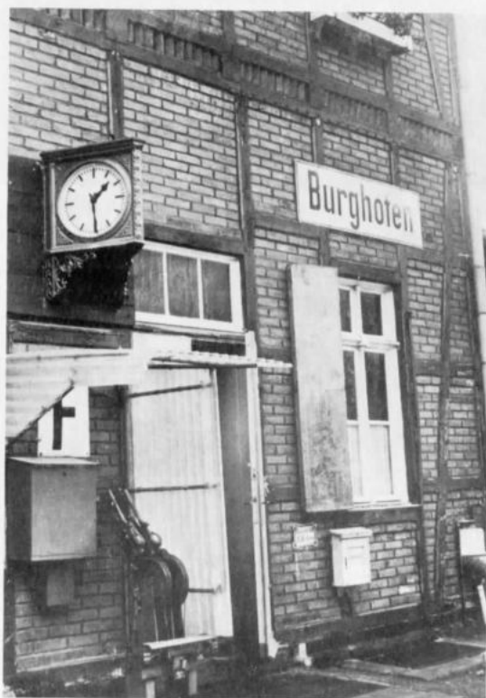
Ein Bild aus Tagen, als der Bahnhof Burghofen noch als solcher genutzt wurde: Das Portal zur Bahnsteigseite mit Weichenhebel, FM-Kasten und mechanischer Außenuhr.
