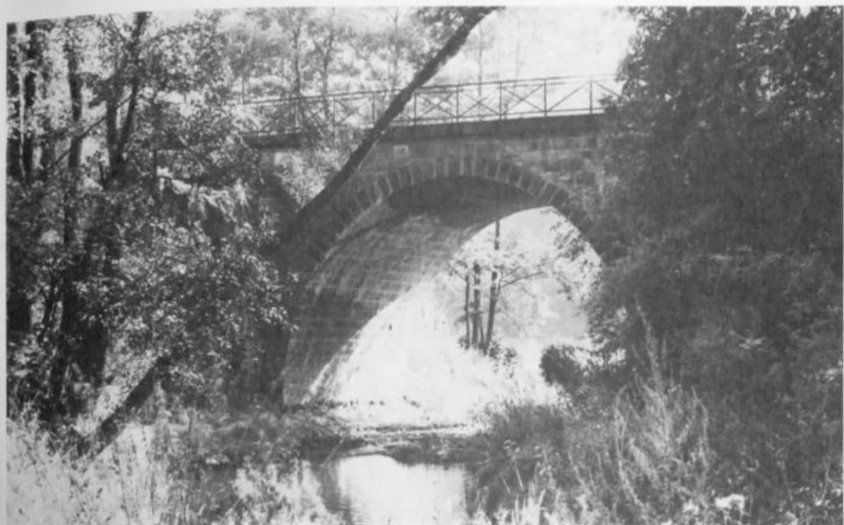
Eisenbahnviadukte fügen sich teilweise malerisch in die Landschaft ein. Hier der Brückenbogen über der Pfiiffe im Bereich des jetzigen Erholungszentrums Spangenberg.
