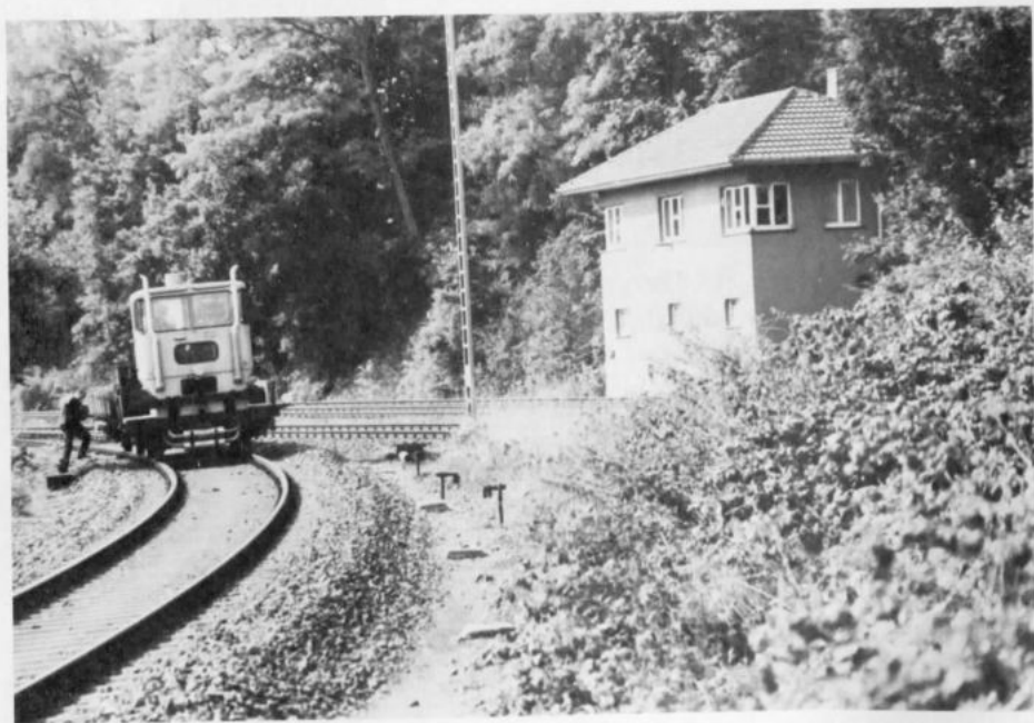
Ein Bauzug auf dem Abzweiggleis zur Hauptstrecke Kassel – Bebra. Rechts das Stellwerk im Bereich westlich des Malsfelder Bahnhofs. Die Aufnahme entstand im August 1982.
