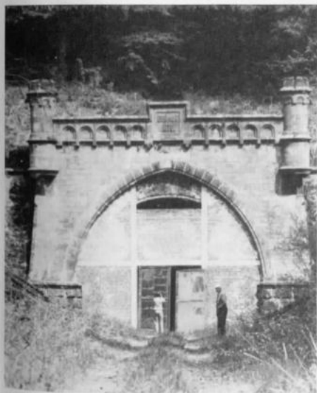
Beide Tunnelportale, von denen das westliche etwas aufwendiger als das östliche gestaltet ist, wurden von der Bundesbahn durch schlichte Backsteinvermauerung gesichert. Trotzdem haben beide Portale über all die Jahre wenig von ihrer Imposanz verloren. Links: Das Tunnelportal Richtung Bischofferode, rechts die Fassade des Tunnels im Fischbachtal, Richtung Burghofen.
