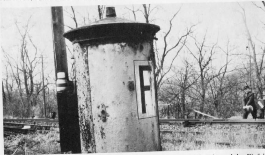
Dieser alte Streckenfernsprecher stand zwischen der hohen Fuldabrücke und der Einfahrt zum Bahnhof Malsfeld. Rechts im Bild an der Weiche steht Oberleitungsmeister Kaspar Schäfer. Er war seinerzeit für die Fernmeldeunterhaltung des Streckenabschnitts Ziegenhain Nord bis zum Tunnel Bischofferode zuständig.
