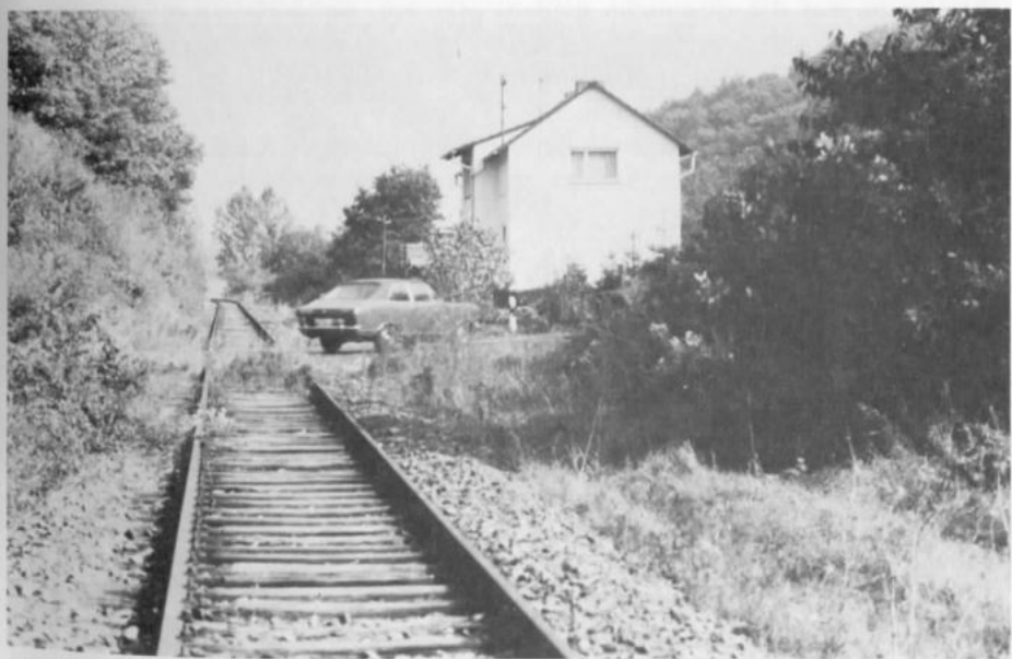
Die „Kanonenbahn“ kreuzt die Landesstraße 3227 im Bereich des alten Bahnwärterhäuschens Spangenberg. Der Übergang war mit einer Schranke versehen, bevor am 20. Mai 1957 hier eine Blinklichtanlage in Betrieb genommen wurde.
