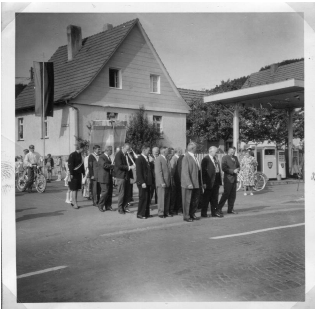
1963 Schollenrat vor Tankstelle Hoppach
