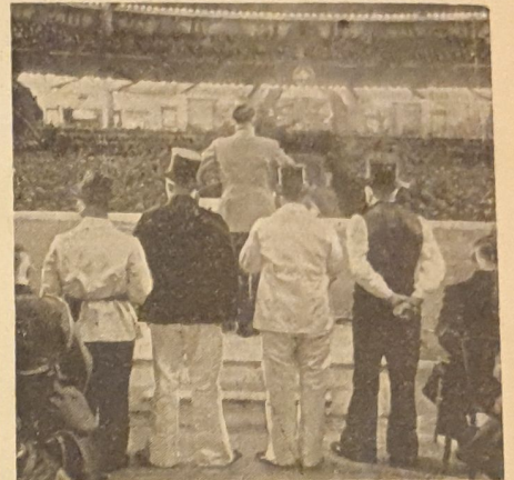
Ein bedeutsamer Abschnitt in der Neugestaltung Berlins. Der Führer spricht auf der Feier zur Einweihung des Neubaus der Reichsfinanzlei zu den rund 8000 Arbeitern, die an diesem Neubauprojekt gearbeitet haben.
