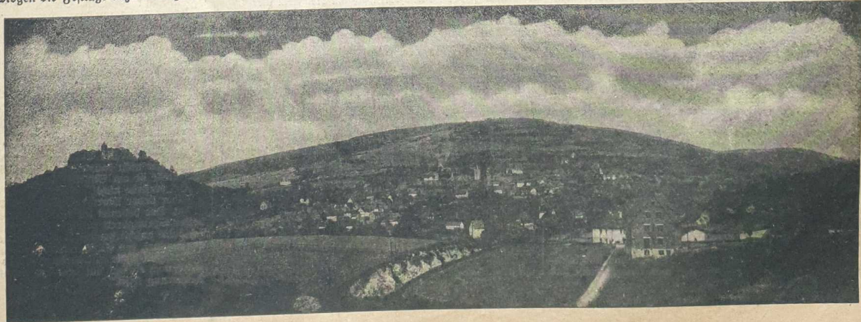
Gesamtansicht Spangenberg mit Schloß
