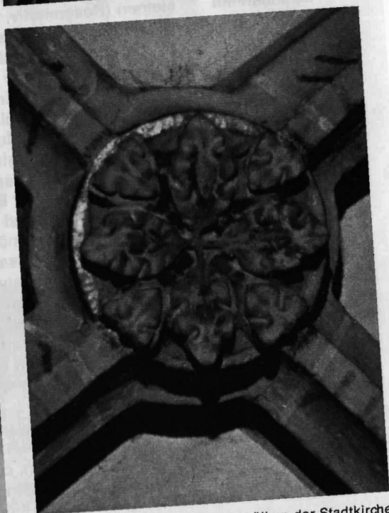
Spätgotische Schlußsteine an den Gewölben der Stadtkirche
