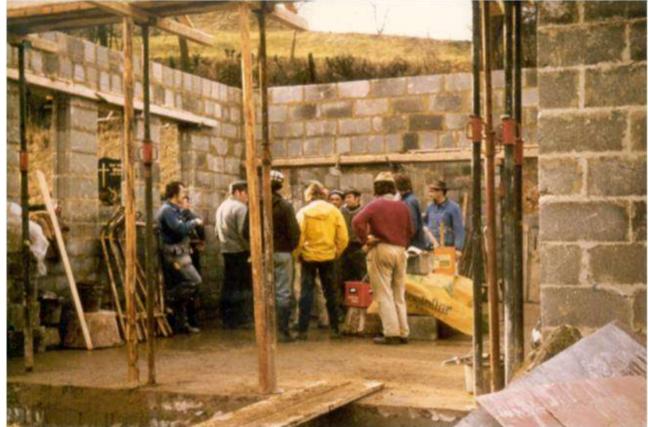
bei der Rohbauabnahme
