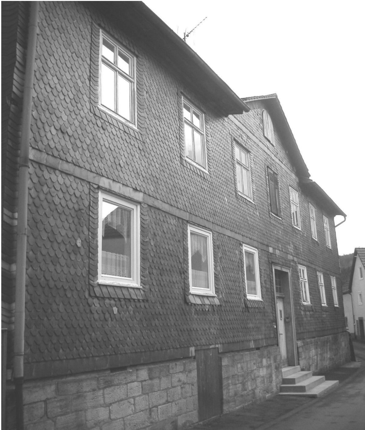
Das Gebäude der ehemaligen Synagoge in der Untergasse heute.
